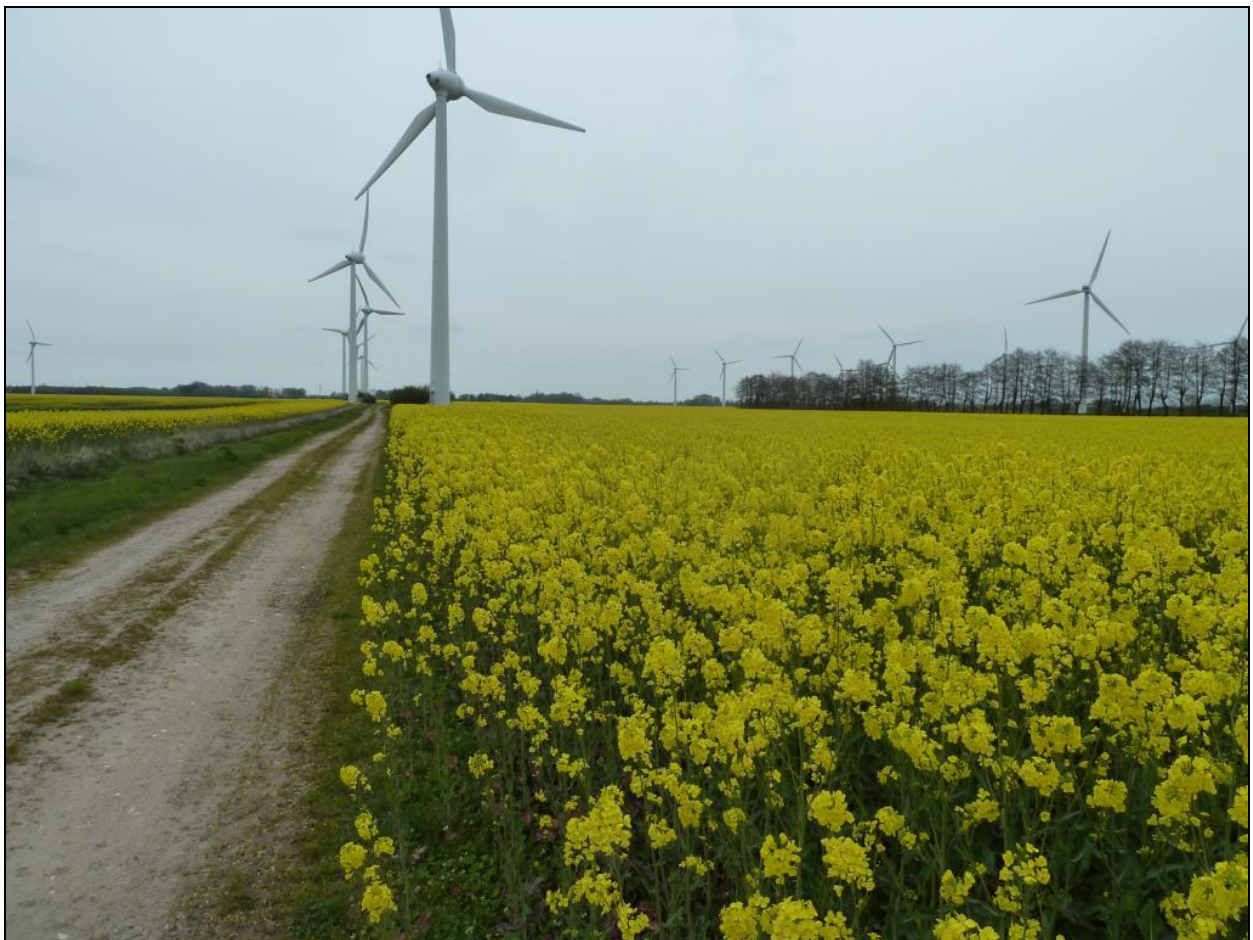
Ansichten des bestehenden Oederquart-Windparks mit Rapsanbau (unten) und dem Wischhafener Schleusenfleth (oben)
